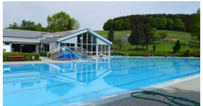
Dachmontage Freibad Gramming
