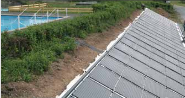
Freiflächenmontage Freibad Niedereisenhausen
