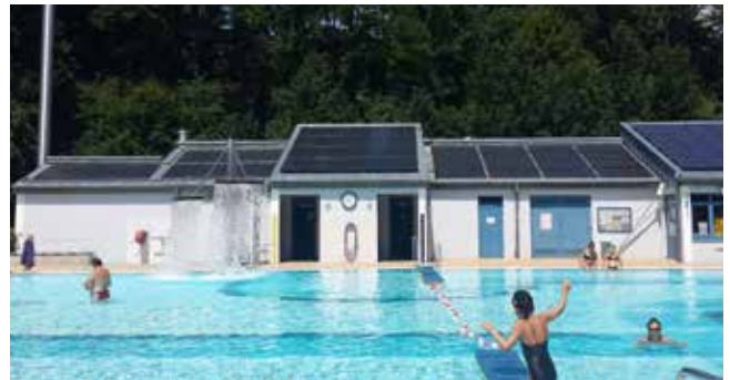
Dachmontage Freibad Mühldorf am Inn
