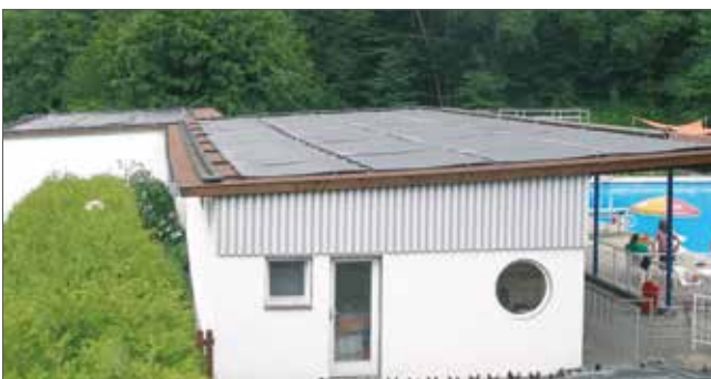
Dachmontage Freibad Holzhausen
