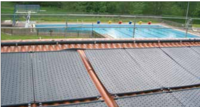
Dachmontage Freibad Knüllwald-Remsfeld
