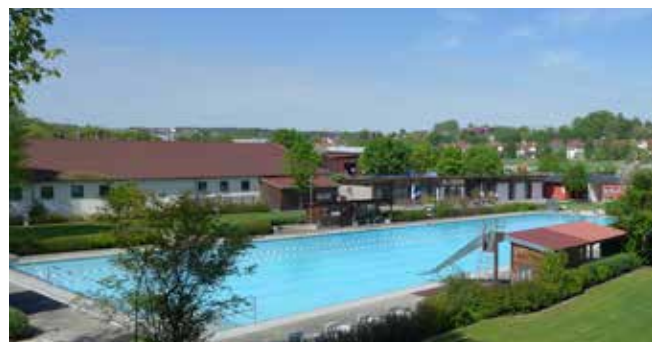
Dachmontage Freibad Arnstorf
