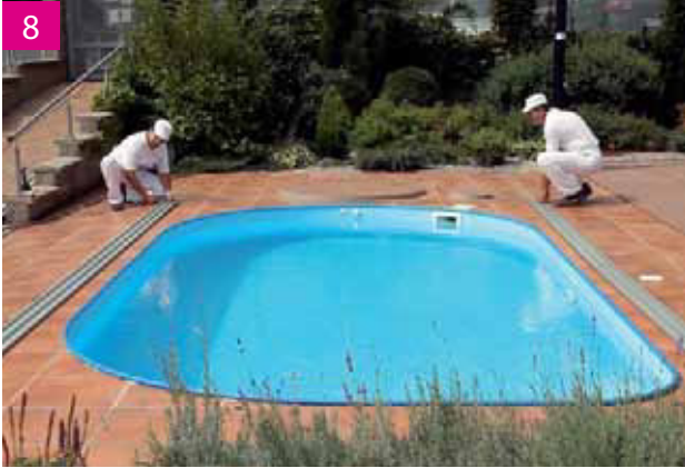
Vermessung der Platzierung der Schienenanlage für die Überdachung
