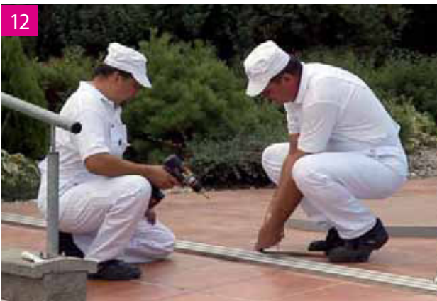
Montage der Schienenverlängerung (falls die Schienenanlage darüber verfügt)
