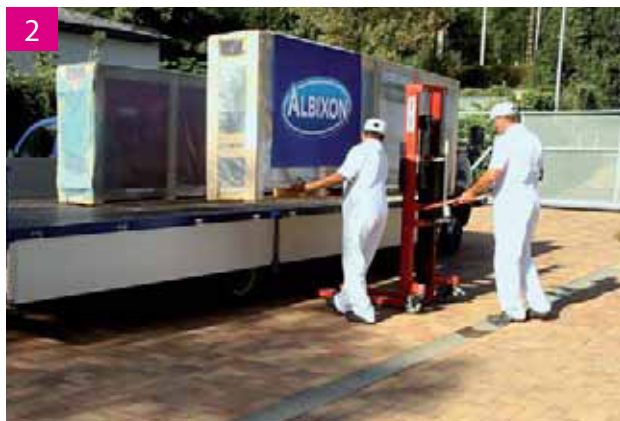
2 Abladung der Überdachung
