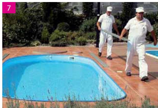
7 Platzierung der Schienenanlage entlang des Schwimmbeckens
