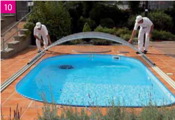
Setzen einzelner Module auf die Schienenanlage
