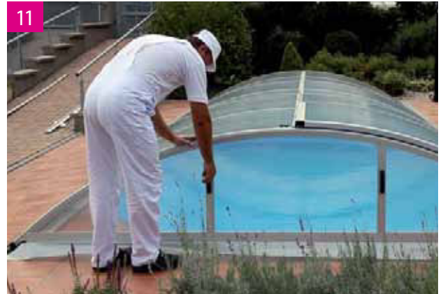
Montage der Vorder- und Rückwand
