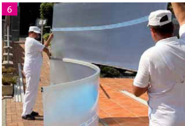
6 Montage einzelner Überdachungsmodule
