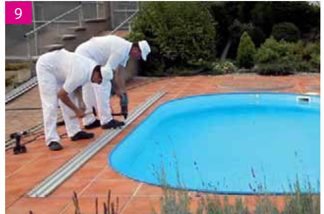
Verankerung der Schienenanlage
